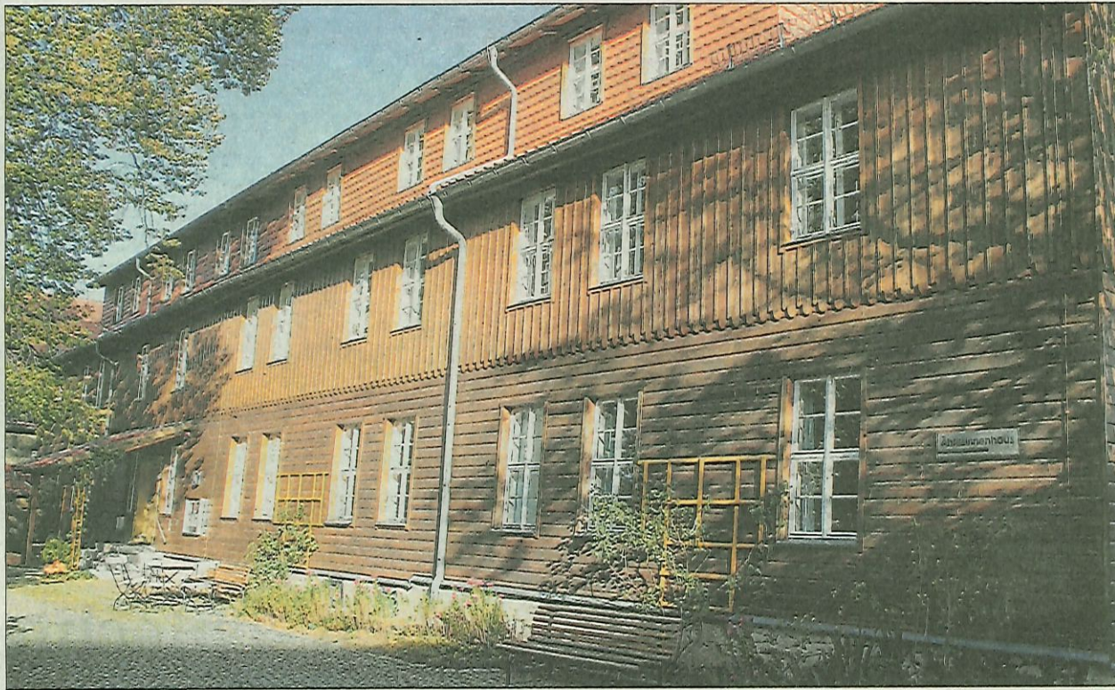
Das Haus der Äbtissinnen im Kloster Drübeck beinhaltet wie viele andere Gebäude des Ensembles Gästezimmer, die mit wenig Aufwand zum Homeoffice hergerichtet werden können. Ab sofort bietet das Kloster diese Möglichkeit zur Miete an. Foto: Jörg Niemann
