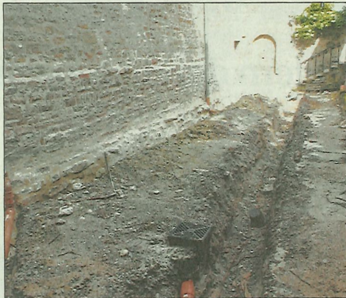
Am Kreuzgang des Klosters Drübeck finden aktuell Tiefbauarbeiten zum Trockenlegen der Kirche statt.
